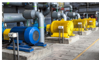
Instalación de Plantas / Equipos
